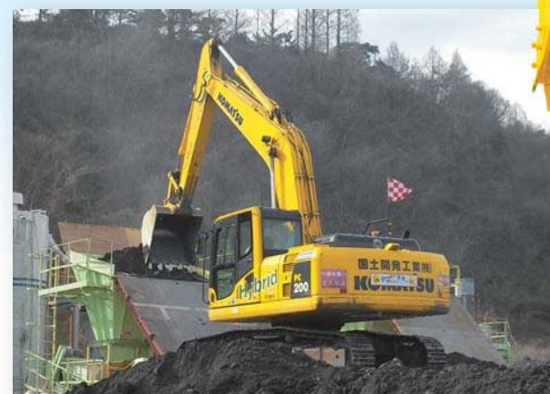
改良土 ホッパー投入(ツイスター工法)
