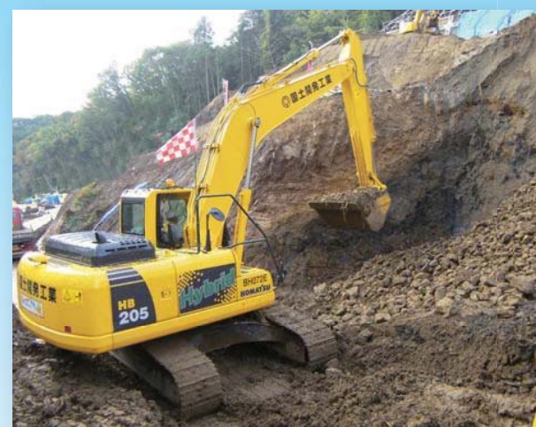
関東地方整備局 葉山島改良工事
