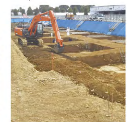
2次掘削のICT建機による施工状況(施工誤差が±30mmのため、根切りの墨出しが不要)
