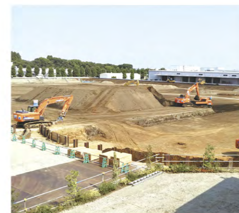
ICT建機による1次掘削作業
