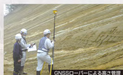
GNSSローバーによる高さ管理
