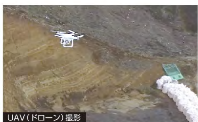
UAV(ドローン)撮影
