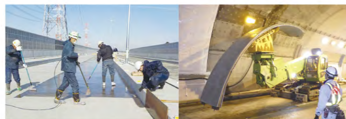
コンクリート床版防水施工
