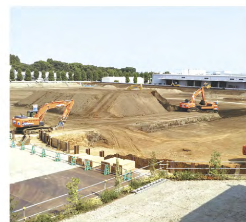
ICT建機による1次掘削作業
