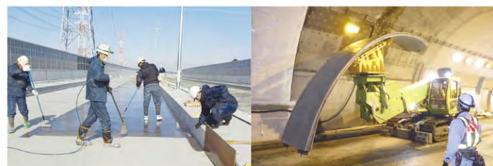
コンクリート床版防水施工
