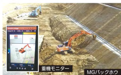
重機モニター MGバックホウ
