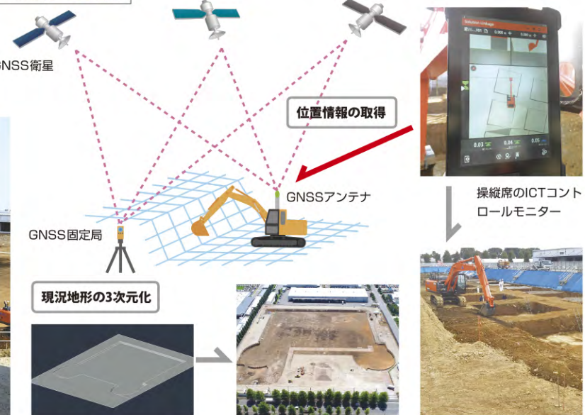
ドローンで敷地計測を行い、3D 掘削計画データを作成(1次掘削 作業計画)
